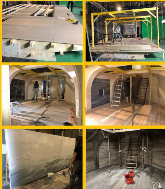
Construction du décor
